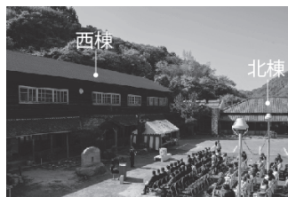
図8. 改修後の西棟, 北棟
