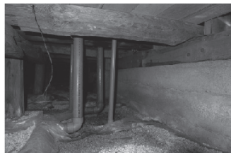
図6. 改修前の西棟床下
