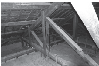
図5. 改修前の西棟屋根裏
